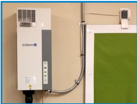
De DriStem XTR elektrode stoombevochtiger in één van de twee bevochtigde klassen op de Aldrich Memorial kleuterschool
